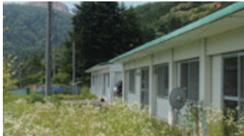
町営集合住宅 (有珠郡壮瞥町滝之町229-10)
